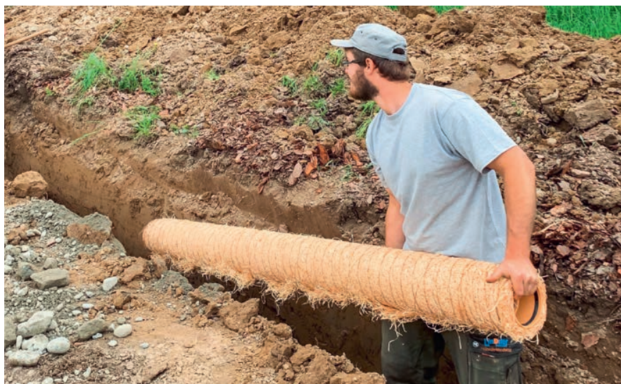
Alternative zum Kiesbett: Die Drainagerohre sind werkseitig bereits mit Geotextil-Filter-Holzwole ummantelt. Die Elemente sind leicht und lassen sich einfach verlegen. Foto: Lindner Suisse
